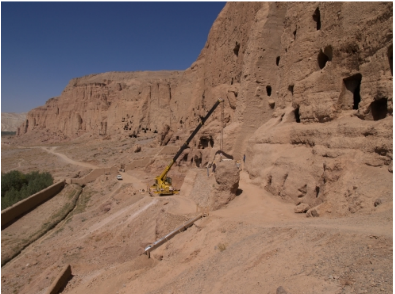
Kl. Buddha: Lagerung von Sand und Kleingeröll über Schütte; Abtransport von Felsfragmenten mit Kran
