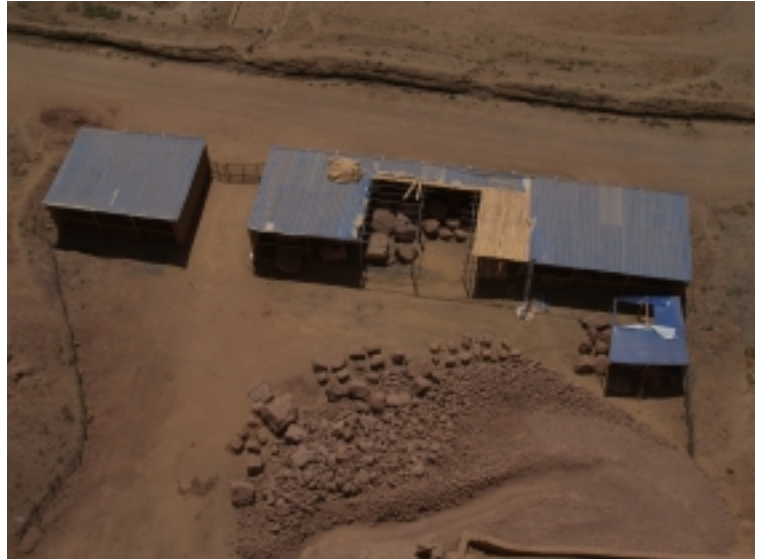
Schutzhallen mit teilweise abgedecktem Dach (wegen Krantransport von Fragmenten). Im Vordergrund Sand- und Geröllhalde (Zustand 19. Aug.)
